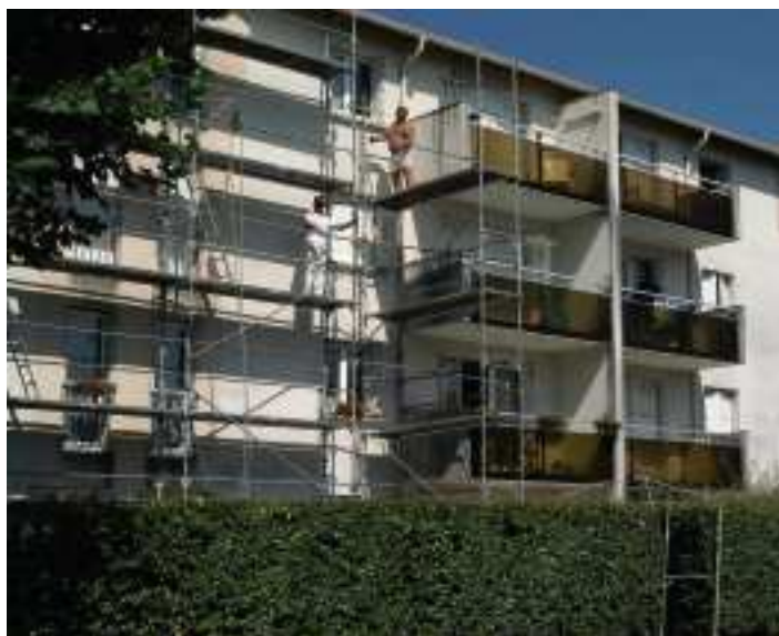
Résidence Andere Beltza (Biarritz) - Travaux de ravalement.
